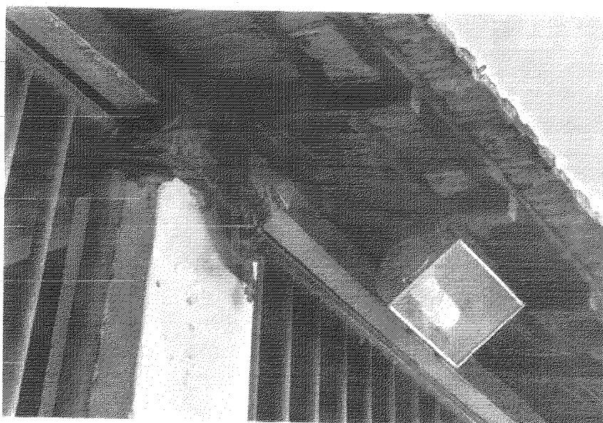
Figura 11: proliferação de cupins
